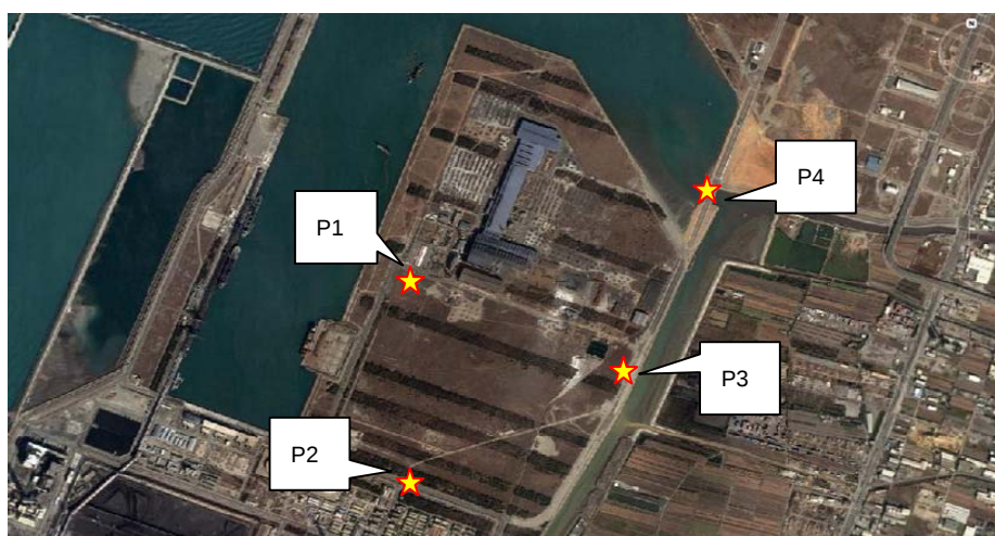
圖 1.4-4 廠址周界噪音振動 4 站(P1、P2、P3、P4)
